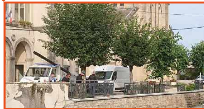
Pose de la barrière devant la mairie
