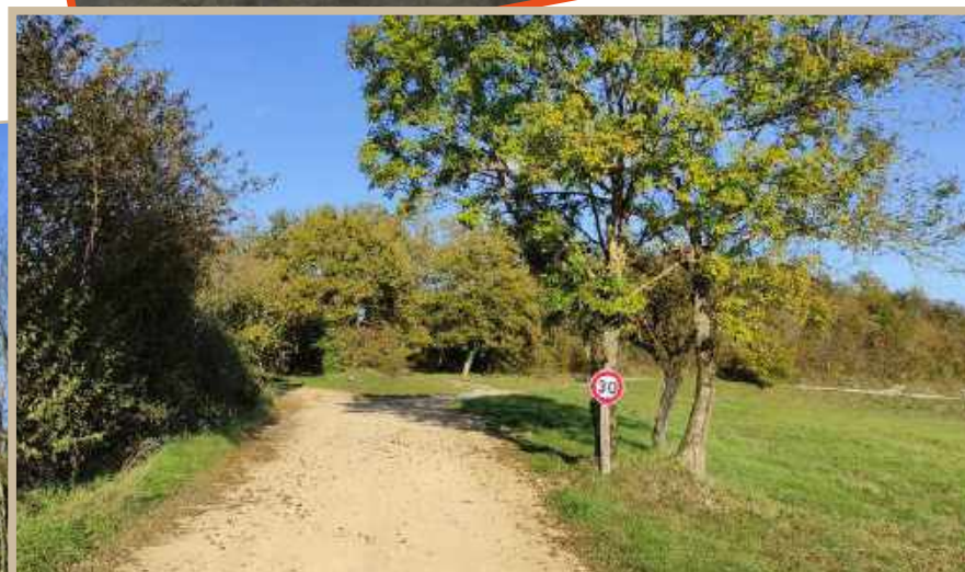
Réfection des chemins à la Grumate
