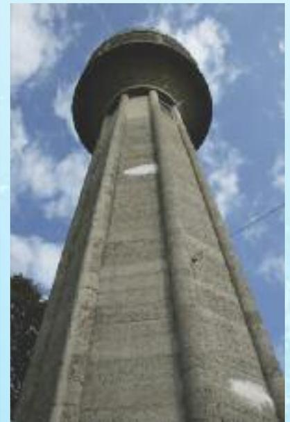
La rouille et le poids des années aidant, notre château d'eau a dû faire l'objet d'une réfection de ses façades. A l'aide d'une nacelle, les « plaies » ont été pansées une à une. La rouille a fait l'objet d'un traitement et les trous ont disparu. Un travail efficace !
